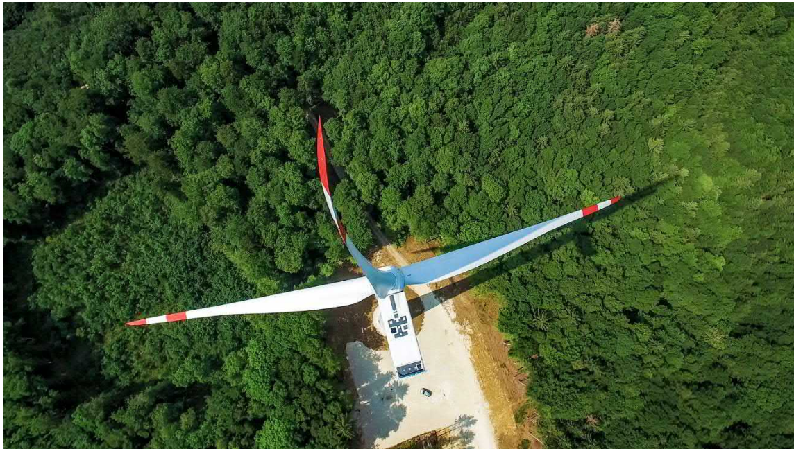
Rund um den Mast wirds später wieder grün: Eine Windenergieanlage im Testbetrieb im Windpark Verenafohren (DE). © DesignConnection GmbH
